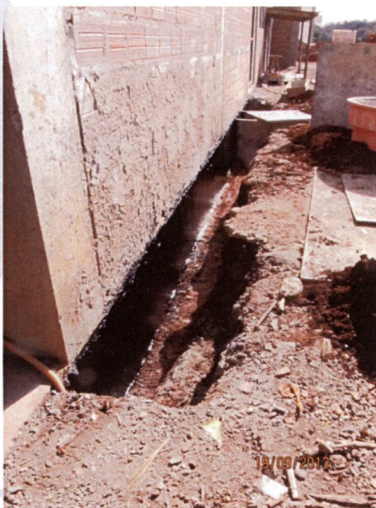
Foto 02: Impermeabilização da viga baldrame
