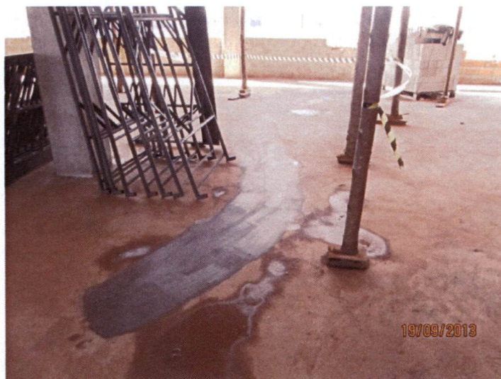
Foto 03: Tratamento sobre a laje
