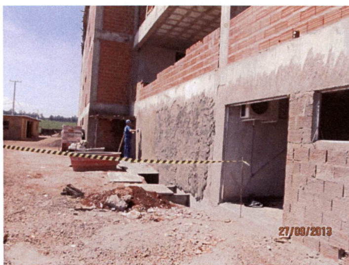
Foto 01: Revestimento da parede externa
