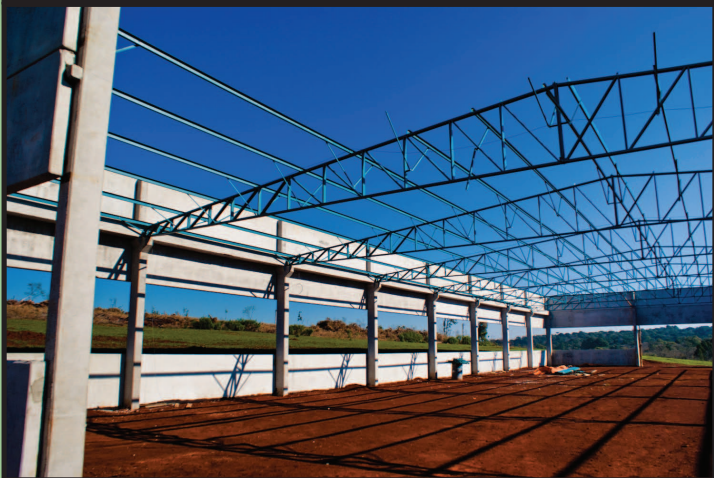
Primeiro bloco de prédios, constituído de dois pavilhões que abrigarão laboratórios, está em fase final de estruturação no campus-sede da UFFS
