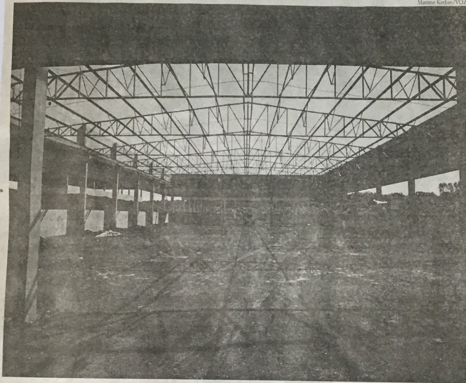
Quatro prédios para laboratórios já estão sendo construídos no terreno da UFFS, na saída para Guatambu
