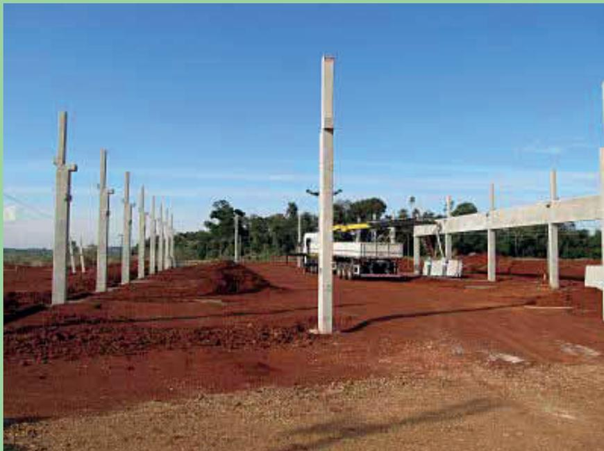
Continua em execução a primeira etapa da construção do Bloco A da Universidade Federal da Fronteira Sul (UFFS) – Campus Realeza. Após a execução da fundação, a empresa responsável pela obra, Rotesma Artefatos de Cimentos Ltda - SC, segue para o levantamento da estrutura pré-fabricada de concreto armado.
