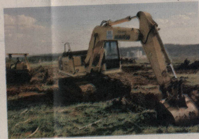
Obras de terraplanagem iniciaram no acesso para universidade
